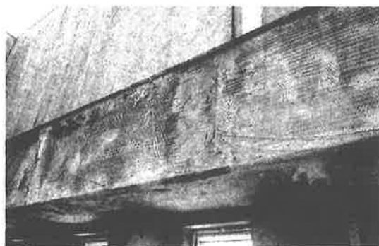
写真3 表面仕上げを施していない当該工法の外壁
